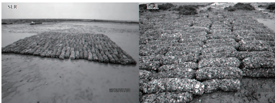
图 3-12: 以牡蛎壳包为底质物构建的单层礁体（左）和多层礁体（右）。其中，单层礁体结构设计：牡蛎壳包依“肩并肩”方式排布，壳包间不留空隙，且礁体结构的长轴方向与水流流向平行；多层礁体结构设计：牡蛎壳包依“肩并肩”方式排布底层后，在上面再排布 1-2 层壳包（全为民等，2017）。
